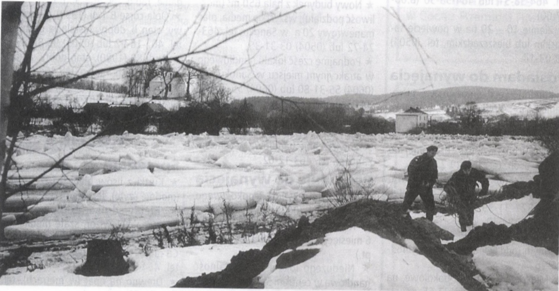
Kruszenie czola zatoru w Wielopolu wymagało od saperów wielokrotnego chodzenia po lodowych taflach.
