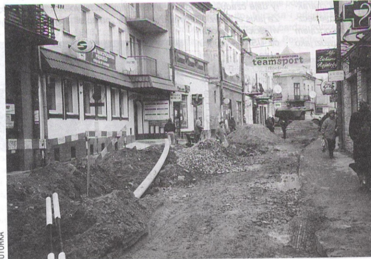
– Wmawia się nam, że prace na ulicy 3 Maja są prowadzone etapami i nie utrudniają dostępu do lokali – mówią rozgoryczeni kupcy.
