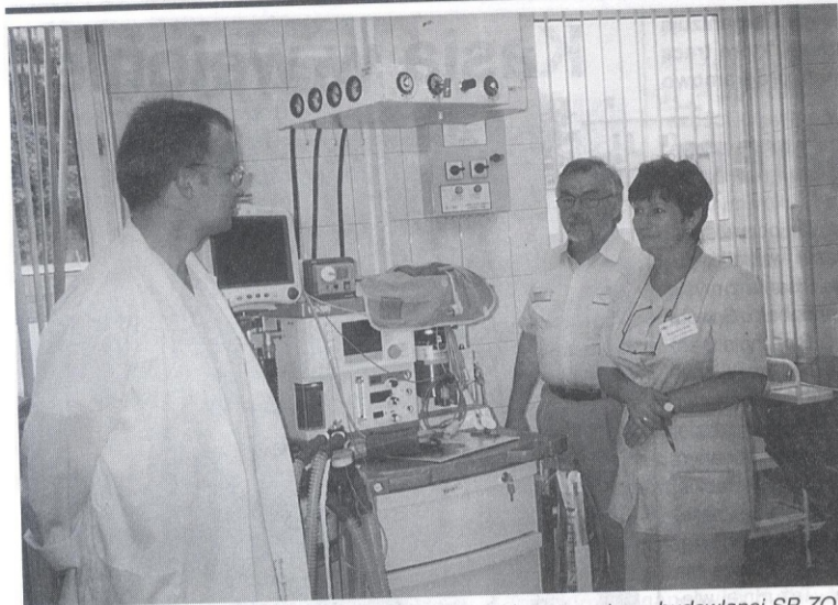
W przekazaniu sali uczestniczyli przedstawiciele ekipy remontowo-budowlanej SP ZOZ, firmy Instal, która odpowiadała za wykonanie instalacji gazów medycznych oraz personel Izby Przyjęć. Inspektor nadzoru Stanisław Kurcoń zapewnił, że nie ma żadnych zastrzeżeń. Na zdjęciu: Bogusława Rudy, pielęgniarka oddziałowa, lek. med. Mariusz Kmiołek i inż. Jerzy Pajura przedstawiciel Instal-Rzeszów.
