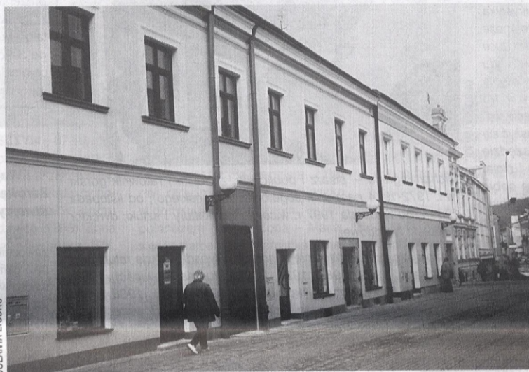
Miejmy nadzieję, że w przyszłym roku doczekamy się renowacji kolejnych budynków w Śródmieściu.
