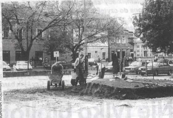
Ekipa firmy Adbud 2 rozpoczęła prace od skucia betonowych płyt, wypełniających wewnętrzną część Rynku.
