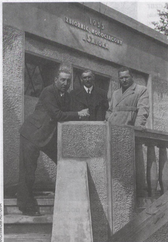
Przy zbiorniku wodociągowym Sanoka w środku stoi Tadeusz Bruna, burmistrz Sanoka.
