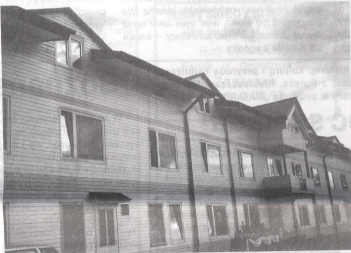
Tak dziś wygląda schronisko – aż trudno uwierzyć, że z niepozornego baraku, jakim kiedyś był ten budynek, stworzono taki obiekt.
