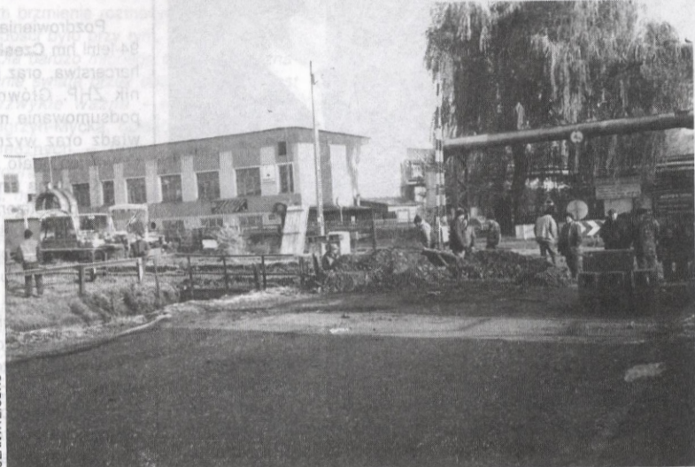
Przez kilka ostatnich dni na przejeździe kolejowym przy ul. Beksieńskiego uwijały się ekipy remontowe Przedsiębiorstwa Napraw i Utrzymania Infrastruktury z Krakowa.
