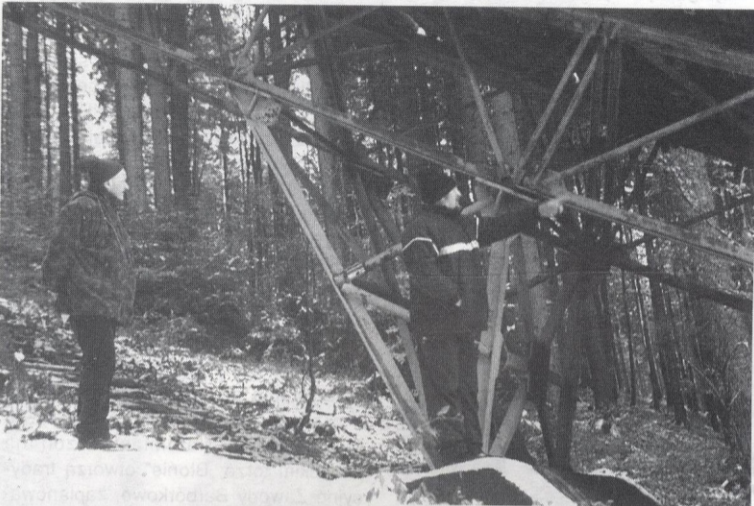
Adam Kiszka, niegdysiejszy skoczek narciarski z Zagórzczu podczas oględzin konstrukcji metalowej najazdu na skoczni w Wiśle-Malinca.
