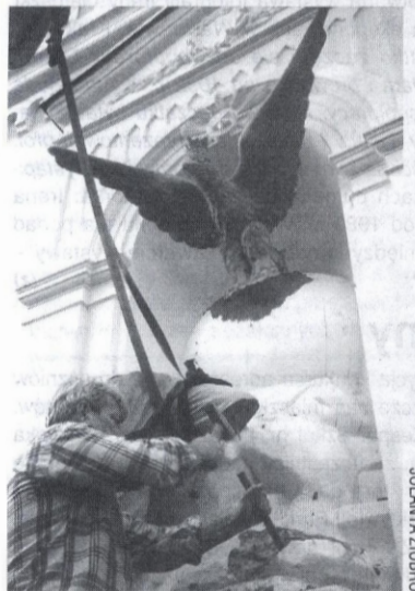
Rzeźba Sokolnika zdobiąca budynek dawnej Sokolnii powróciła na swoje miejsce po wielu latach niebytu – uroczyste jej odsłonięcie poprzedził kilkugodzinny montaż.
