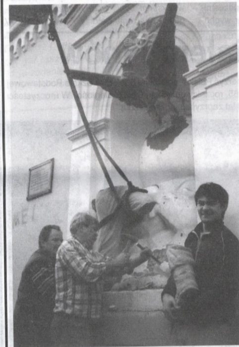
Podczas montowania grupy rzeźb na obiekcie Sokoła.
