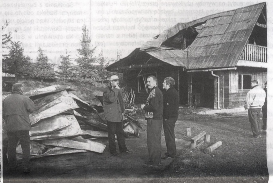
Na dymiących jeszcze zgłiszczach ośrodka zarząd KOZZ jednogłośnie postanowił go odbudować.
