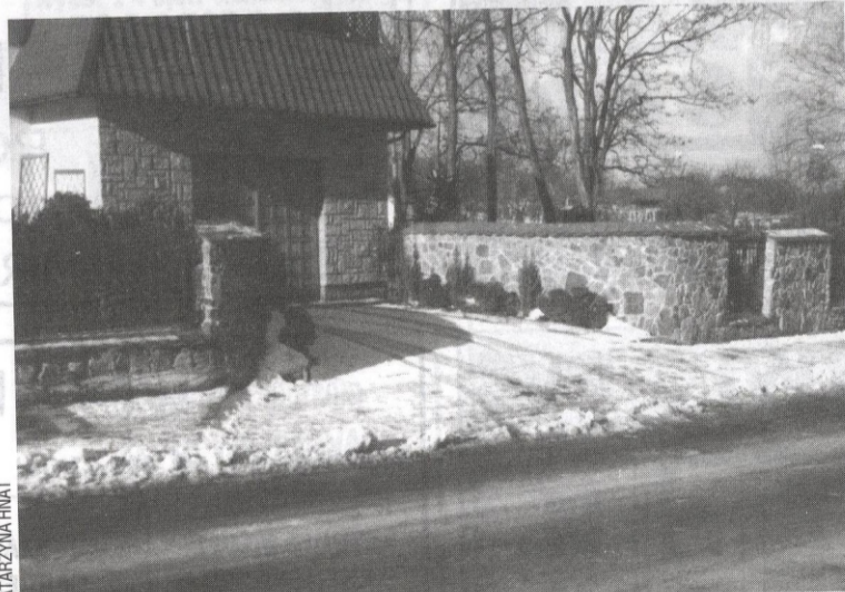
Wysoki podjazd stwarza zagrożenie dla użytkowników chodnika.
