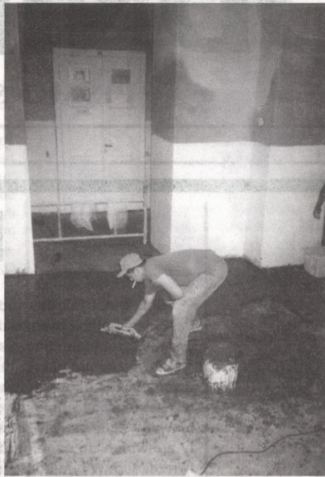
W G2 trwa kapitalny remont holu szkoły.
