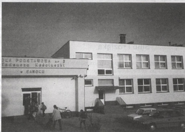
Prosto spod igły – z zewnątrz budynek SP3 wygląda jak nowy. Od ubiegłego roku obiekt jest również monitorowany, co pozwala mieć nadzieję, że wandalę będą trzymali się od niego z daleka.
