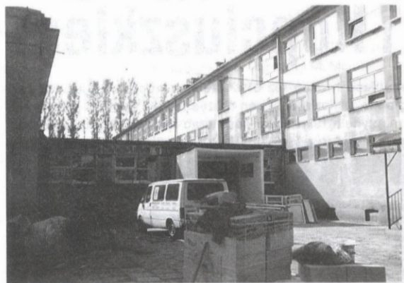
„Jedynka” na pewno potrzebuje solidnego remontu.
