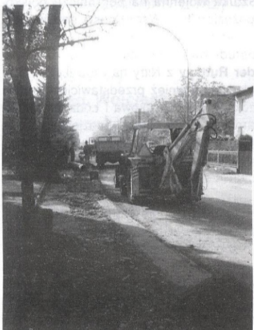
Dopiero po wykonaniu odwodnienia można pomyśleć o nowej nawierzchni ul. Robotniczej.
