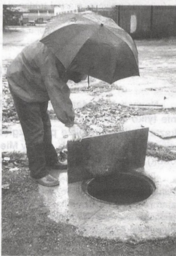
Początkowo studzienki były zabezpieczone samymi płytami październikowymi...
