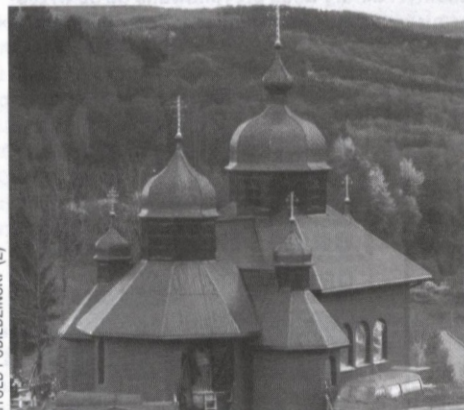
Cerkiew św. Michała Archanioła w budowie, maj 2005 r.
