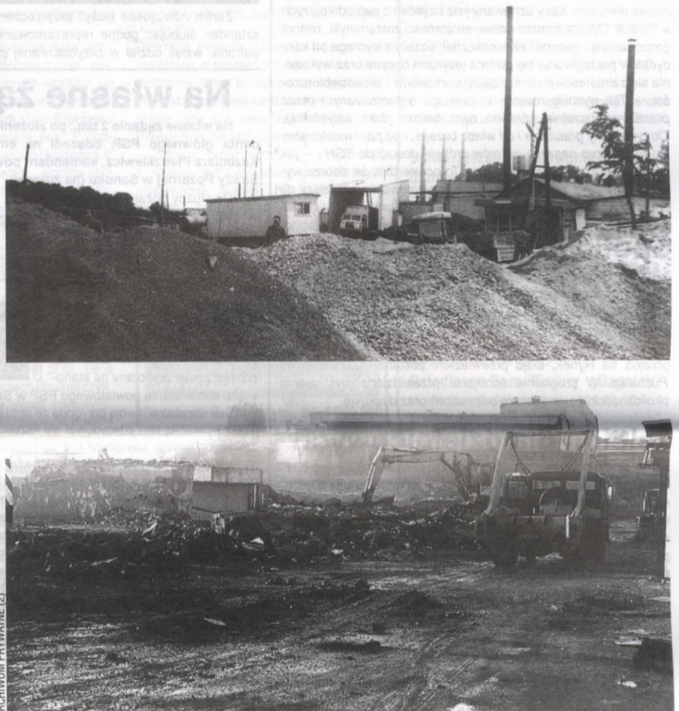
Góra: tak budowano zakłady mięsne w Sanoku... Dół: ...a tak rozburzano. Gdzieś w środku był Beef-San...
