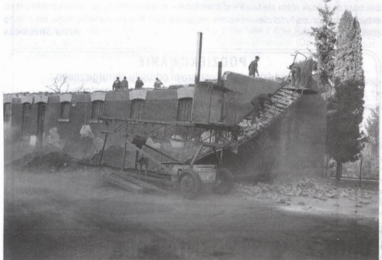
Tuż przed kolejnymi opadami śniegu, 1 bm., przy niedgdyjszych stajniach dla koni trwały wyłożone prace.
