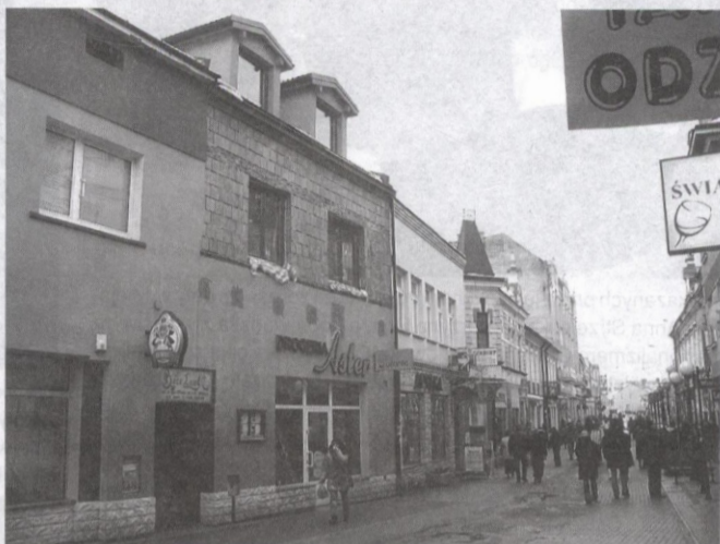
Przy życzliwości władz remont kamienicy mógł być dawno skończony.
