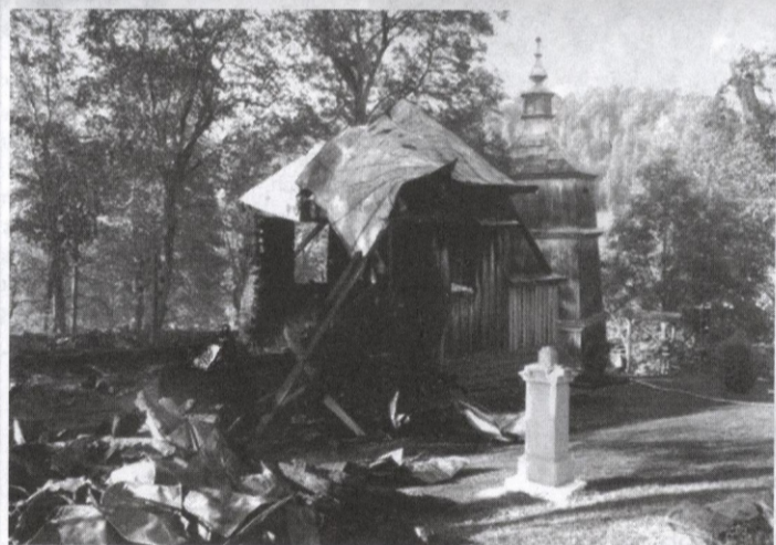
Mimo ogromnego wysiłku strażaków świątyni nie udało się uratować. Zostały po niej zgłiszcząca – nadpalone kawałki drewna i pogięte blachy. Ocalała tylko dzwonnica i krzyż.
