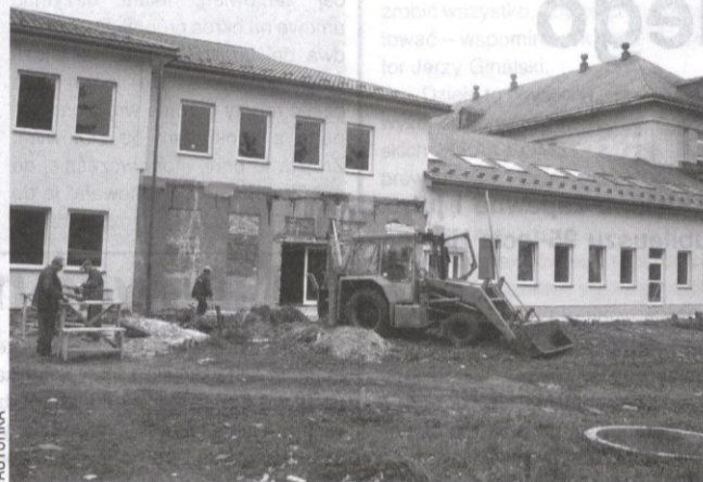
Roboty idą pełną parą. Budowlancy uwijają się w gabinetach, laboratoriach i na sali operacyjnej, a na zewnątrz kończą elewację.
