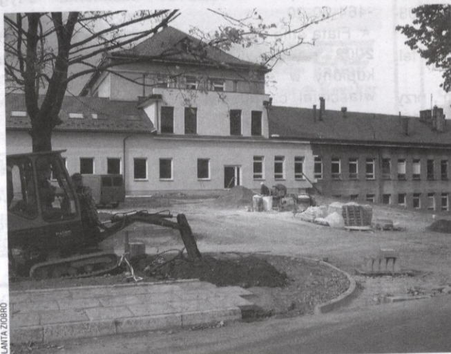
(jz) Wjazd i główne wejście do powstającego Oddziału Ratunkowego.
