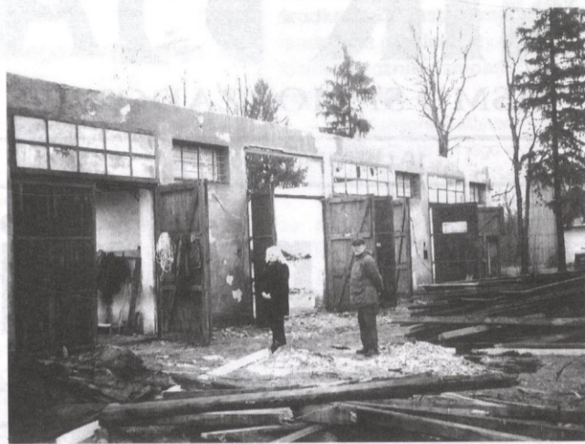
Zdewastowany budynek starego garażu zamieni się jeszcze w tym roku w krytą ujeżdżalnię
