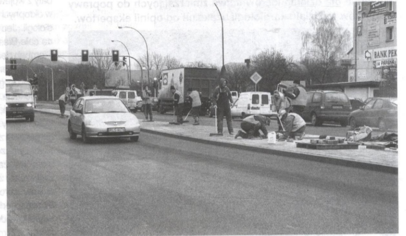
Remontowi sanockiej obwodnicy mieszkańcy miasta przyglądają się bardzo wnikliwie. Niestety, przeważają opinie krytyczne.
