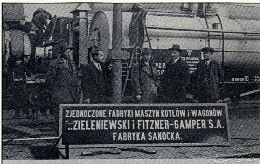
Zjednoczone Fabryki Maszyn Kotłów i Wagonów Zieleniewski i Fitzner-Gamper S.A. Fabryka Sanocka, 11 stycznia 1935 – Julian Gorgoń drugi od lewej.
