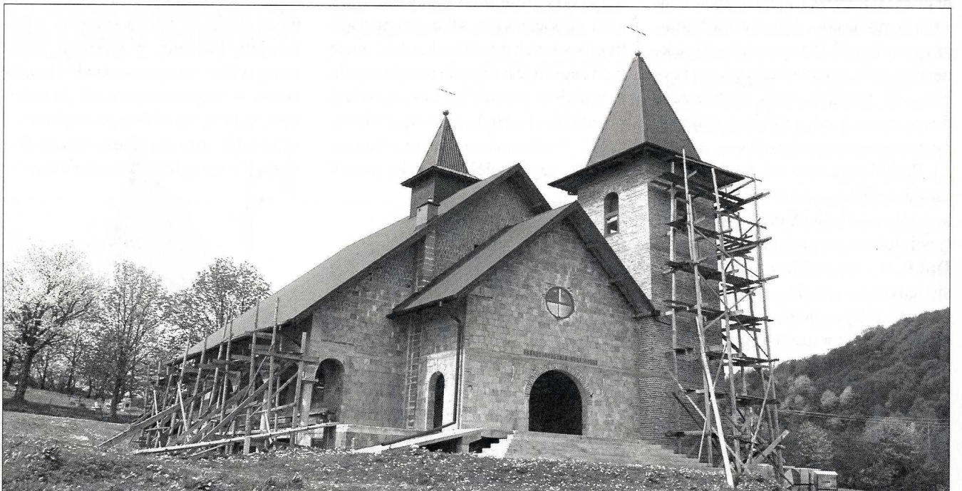
Budowa kościoła w Terce
