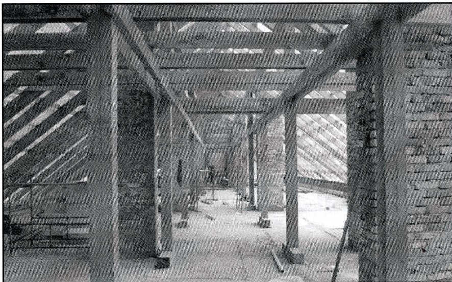
Nowa więźba dachowa
