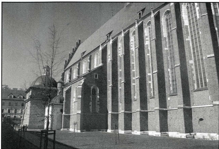
zdjęcie od strony południowej, widoczne gotyckie umocnienia ścian i dobudowana kaplica
