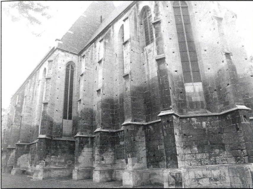
kamienna ściana zewnętrzna prezbiterium i nawy kolegiaty z gotyckimi przyporami
