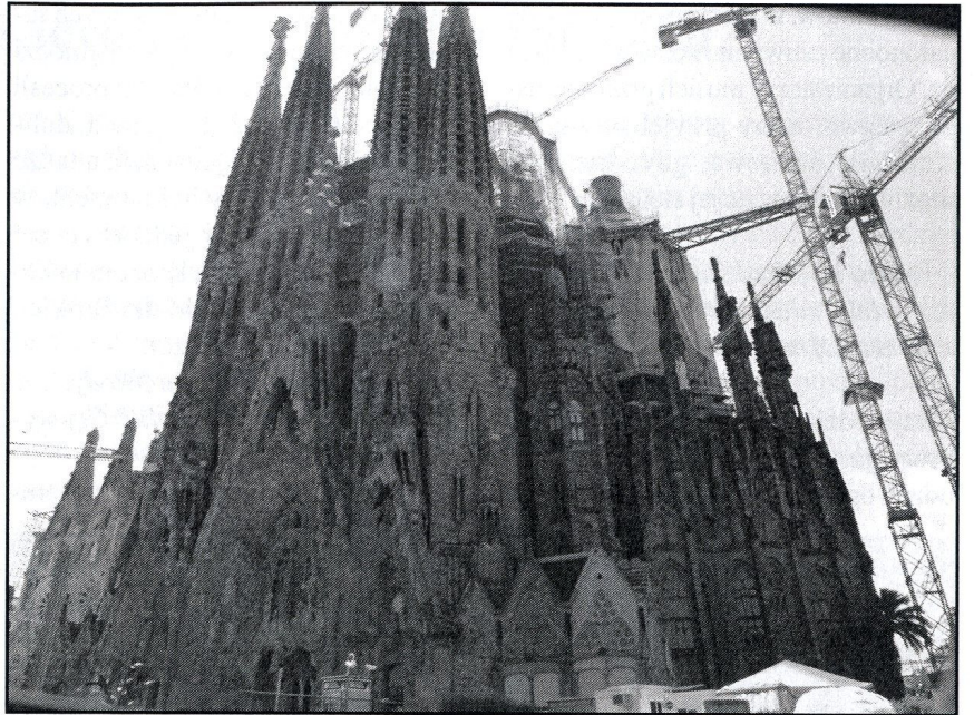
obecny stan prac przy „Sagrada Familia” w Barcelonie
