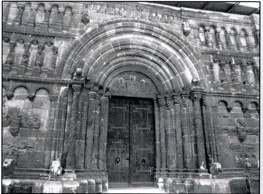
portal kościoła św. Jakuba w (prawie) całej okazałości, widoczne obramowanie, tympanon i trzy kondygnacje w pionie całej konstrukcji
