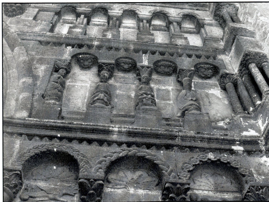
widok na drugie i trzecie „piętro” portalu, widoczne kariatydy
