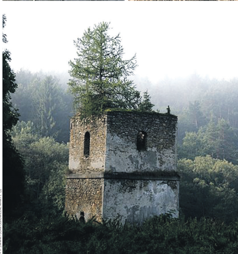
Pierwsze cztery fotografie przedstawiają prace remontowe przy dzwonnicy, które odbyły się w 2013 r. Na piątej fotografii dzwonnica z 2005 r.
