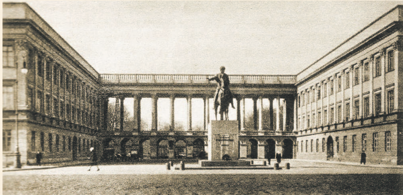
Pałac Saski w Warszawie, międzywojenna siedziba Biura Szyfrów
