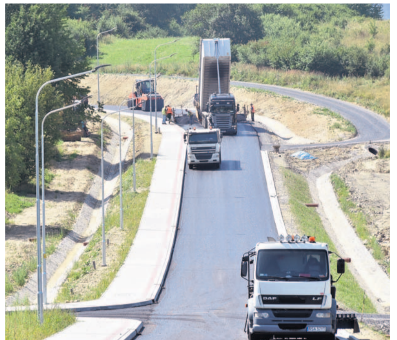
Ostatni etap prac przy łączniku do ul. Łany
