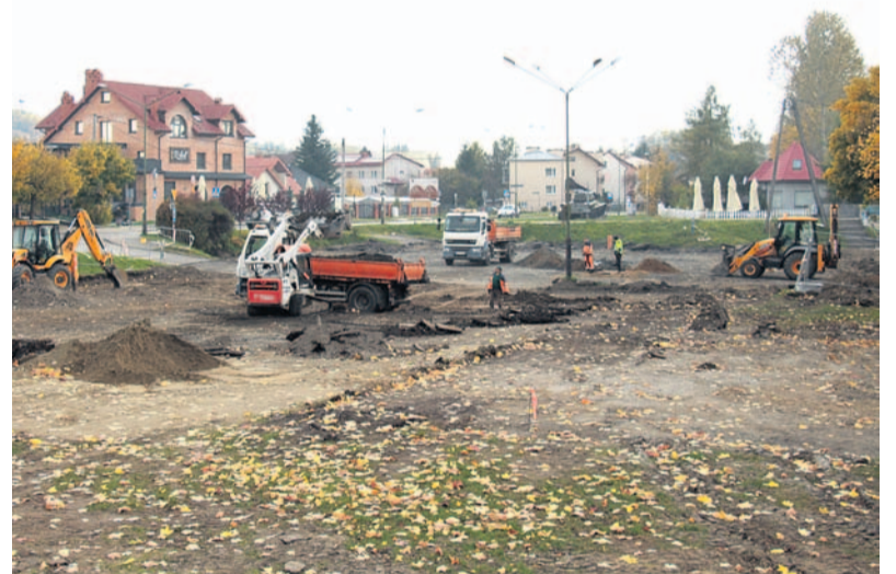
Budowa parkingu i kompleksu sportowo-rekreacyjnego przy ul. Białogórskiej
