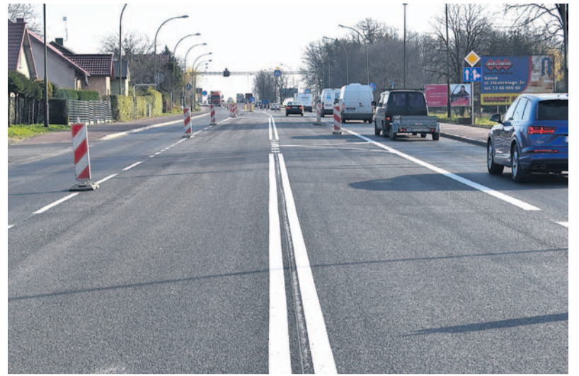
Ul. Krakowska po remoncie
