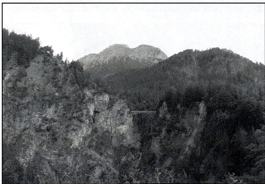
widok na zawieszony nad przepaścią most Marienbruecke
