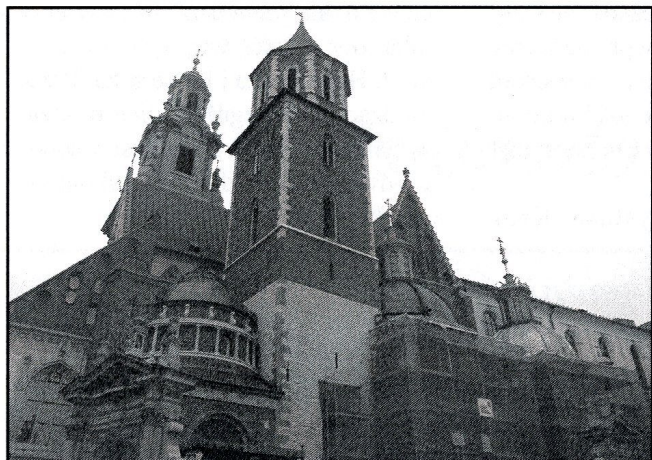
katedra wawelska od strony południowej, trwa remont kaplic
