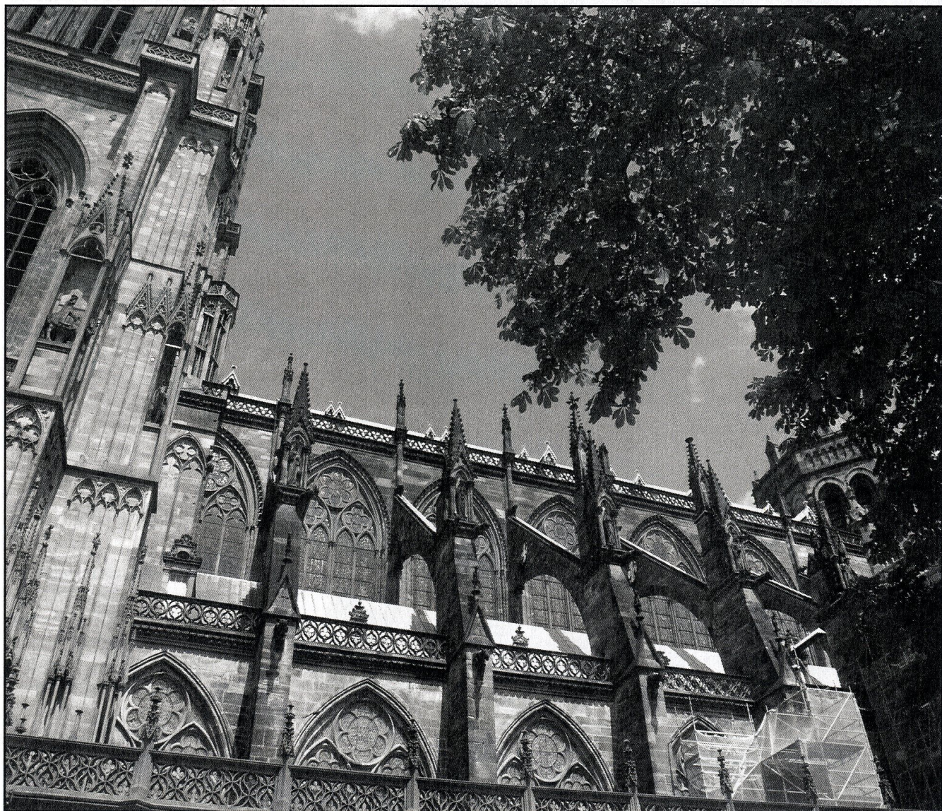
widok od strony południowej na górną część nawy z przyporami
