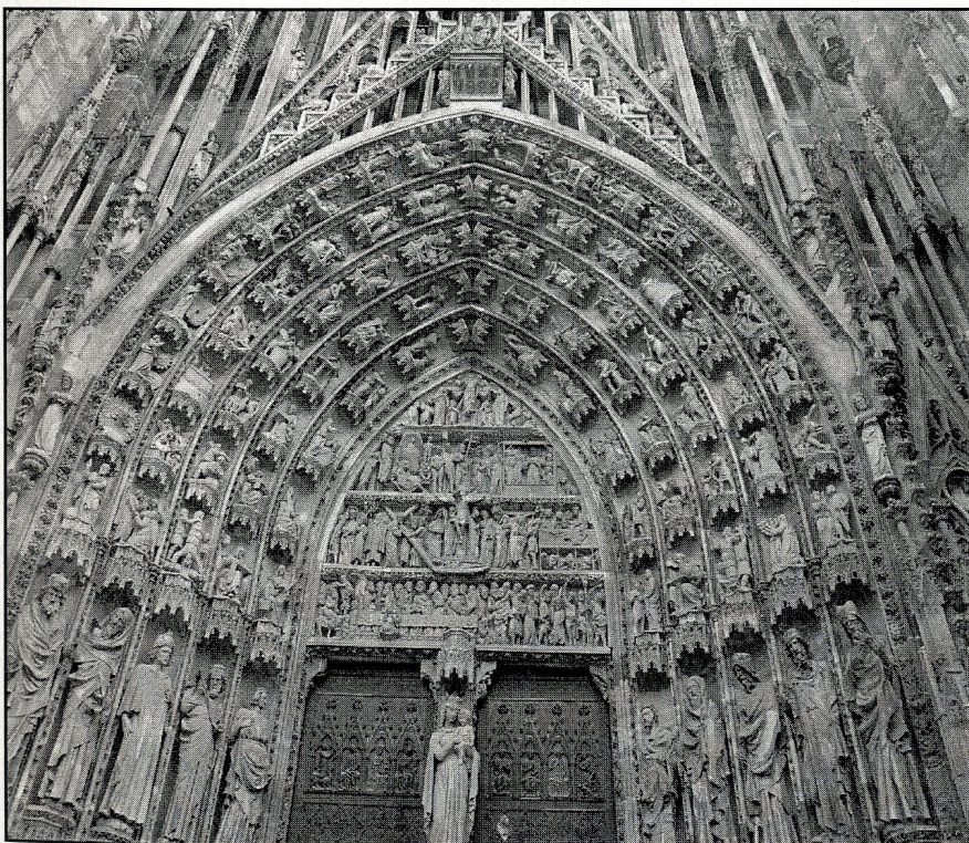
główny portal reprezentacyjnej fasady – widoczne posągi proroków, „trumeau”, tympanon i archiwolty
