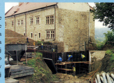
Odbudowa skrzydła zamkowego.
