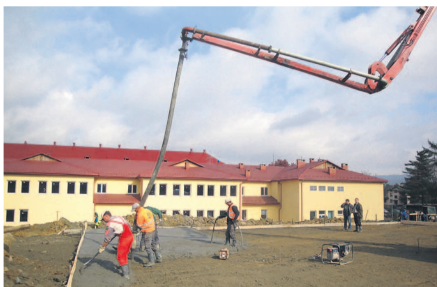
Budowa lądowiska dla helikopterów, 2010 r.
