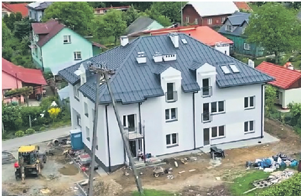
Prace przy remoncie bloku przy ul. Pięknej na ukończeniu
