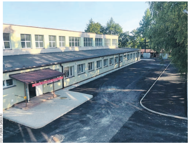
Modernizacja RCRE na ukończeniu
