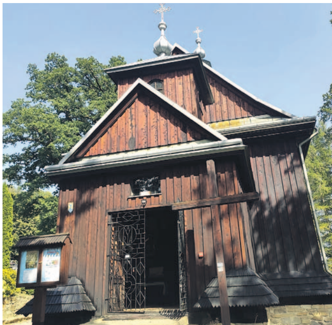
Świątynia w Górzance od lat jest remontowana
