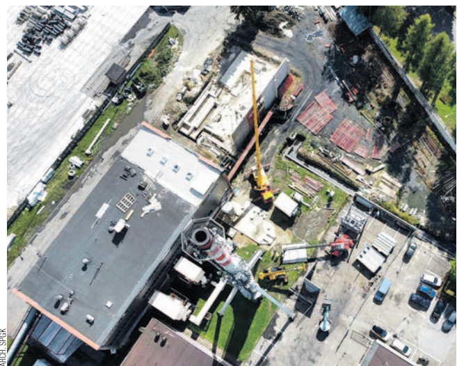
Prace przy kotle na biomasę idą pełną parą
