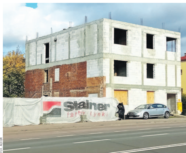
Aktualny stan podczas przebudowy w 2023 r.
