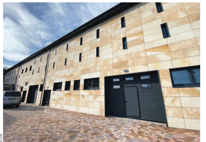
Nowy budynek magazynowy MBL
