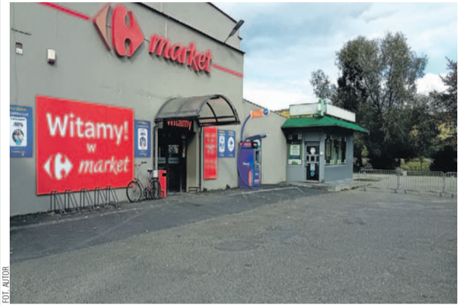
Wejście do Carrefoura bez oznaczenia miejsc parkingowych dla niepełnosprawnych
