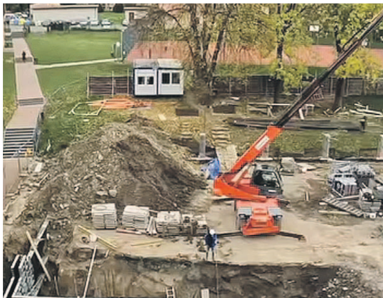
Plac budowy sali gimnastycznej przy SP2
